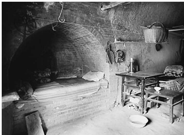
Свод над каном, укрепленный кирпичной кладкой
