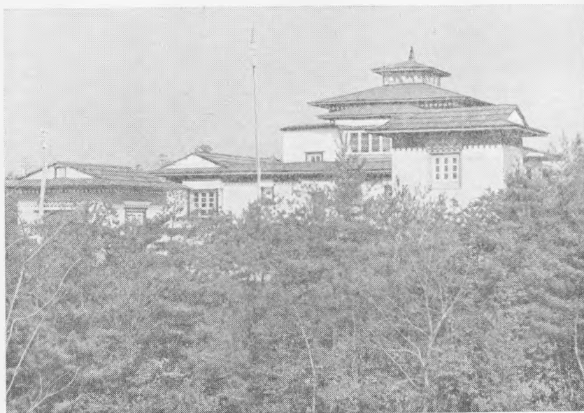
Рис. 6. Строительство непальского монастыря в основном уже закончено
