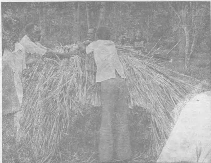
Рис. 6. Покрытие тростником каркаса крыши хижины с Тонгоа
