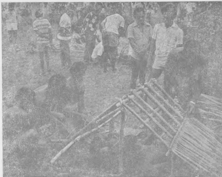
Рис. 4. Способ покрытия хижин пальмовыми листьями
