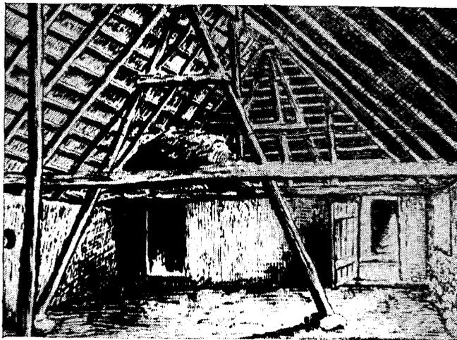
Рис. 8. Конструкция крыши датского крестьянского дома (вид изнутри)
