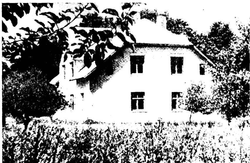
Рис. 9. Четырехквартирные жилые дома в сельхозартели им. Ленина Талсинского р-на. Стены сооружены из торфопанелей, обшитых кирпичом
