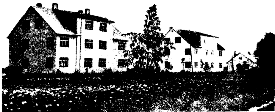
Рис. 11. Трехэтажные многоквартирные здания в новом поселке совхоза «Мадона» в Лаздоне
