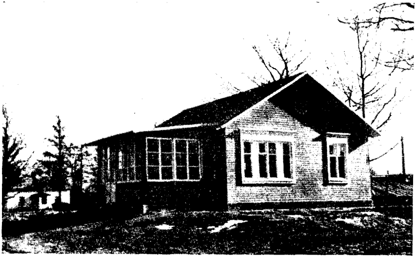
Рис. 10. Сборные стандартные домики из панелей заводского производства в сельхозартели «Заля земе» Огрского р-на
