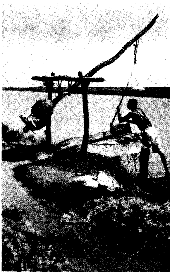
Рис. 7. Суданский крестьянин у шадуфа (водоподъемного сооружения)
