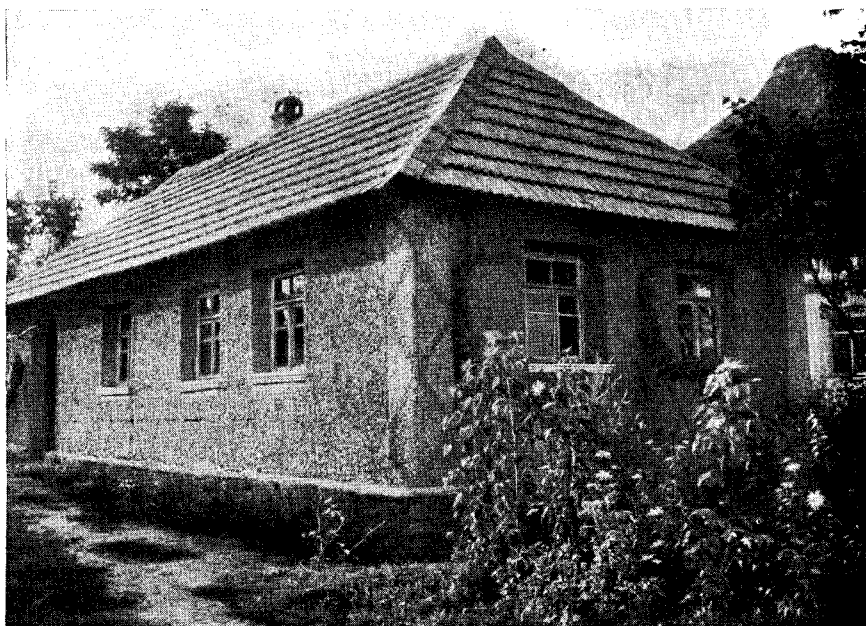
Рис. 1. Жилой дом колхозника с обработкой пилястр кирпичным боем красного и белого цвета, с. Лесоводы Городокского р-на Хмельницкой обл. (фото автора)
