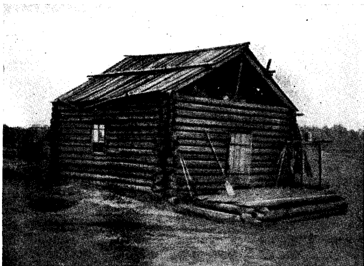
Рис. 11. Хантыйское срубное жилище с двускатной крышей на коньковом стояке, р. Казым (архив Ин-та этнографии)
