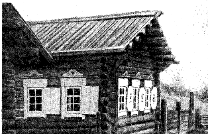
Рис. 3. Клетская изба с кровлей на самцах, повалах и курицах. Дер. Верхнее Суворово
